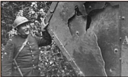
Luitenant Frevez, AS 37, toont de schade aan zijn tank die is veroorzaakt door een Duitse granaat.
